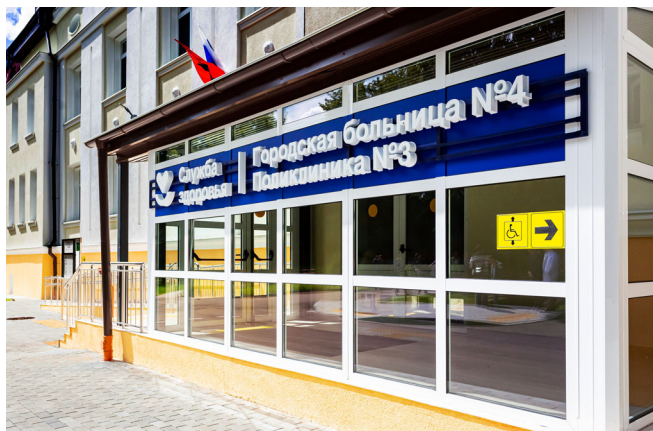
Рисунок 2. Реализация мероприятий федерального проекта «Модернизация первичного звена здравоохранения» по обновлению материально-технической базы медицинских организаций в части проведения капитального ремонта/строительства/реконструкции/монтажа модульных конструкций и приобретения объектов недвижимого имущества
